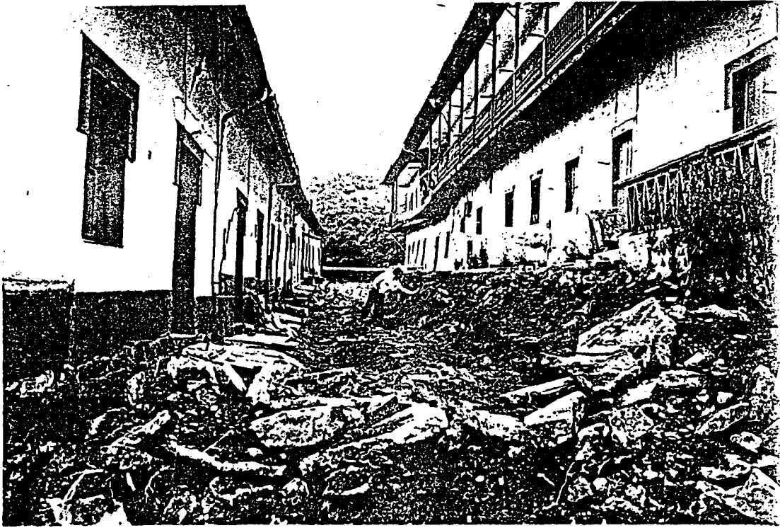
Fig. 3.- Grieta entre Los Cuarteles, el 31 de Mayo.
